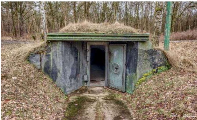
FIGURA 40: túnel Maybach (lastfordecades)
